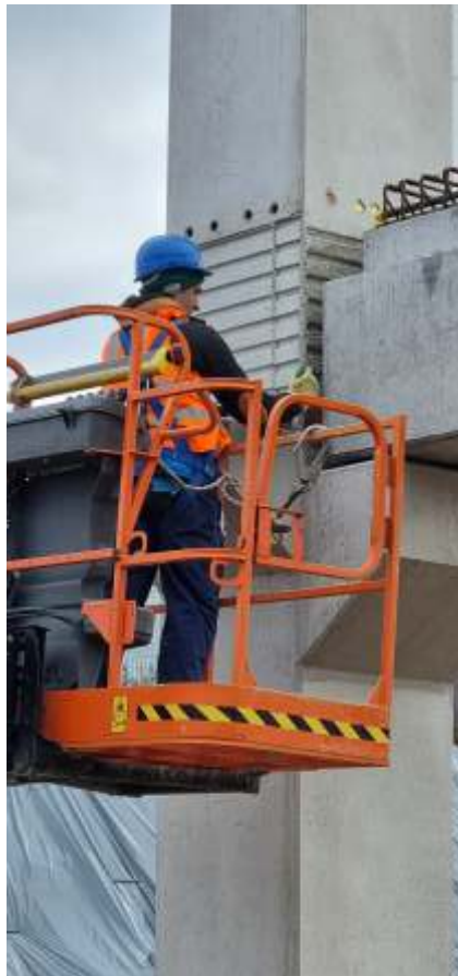
Pregătirea îmbinării rigide Rigid joint preparation
