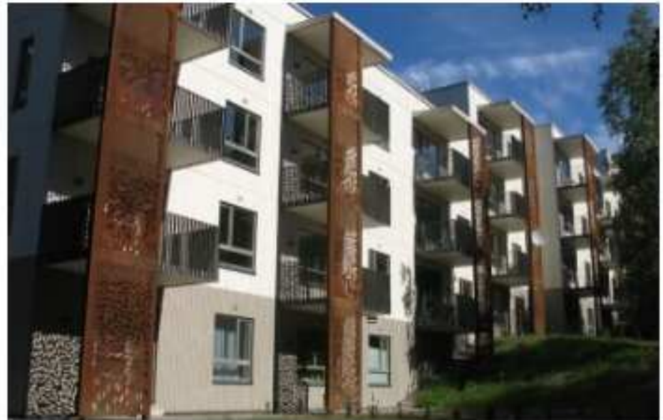
RESIDENTIAL BUILDINGS "BAJORŲ DOMINIJA"
