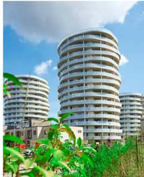
Istaarn Residence, Denmark
