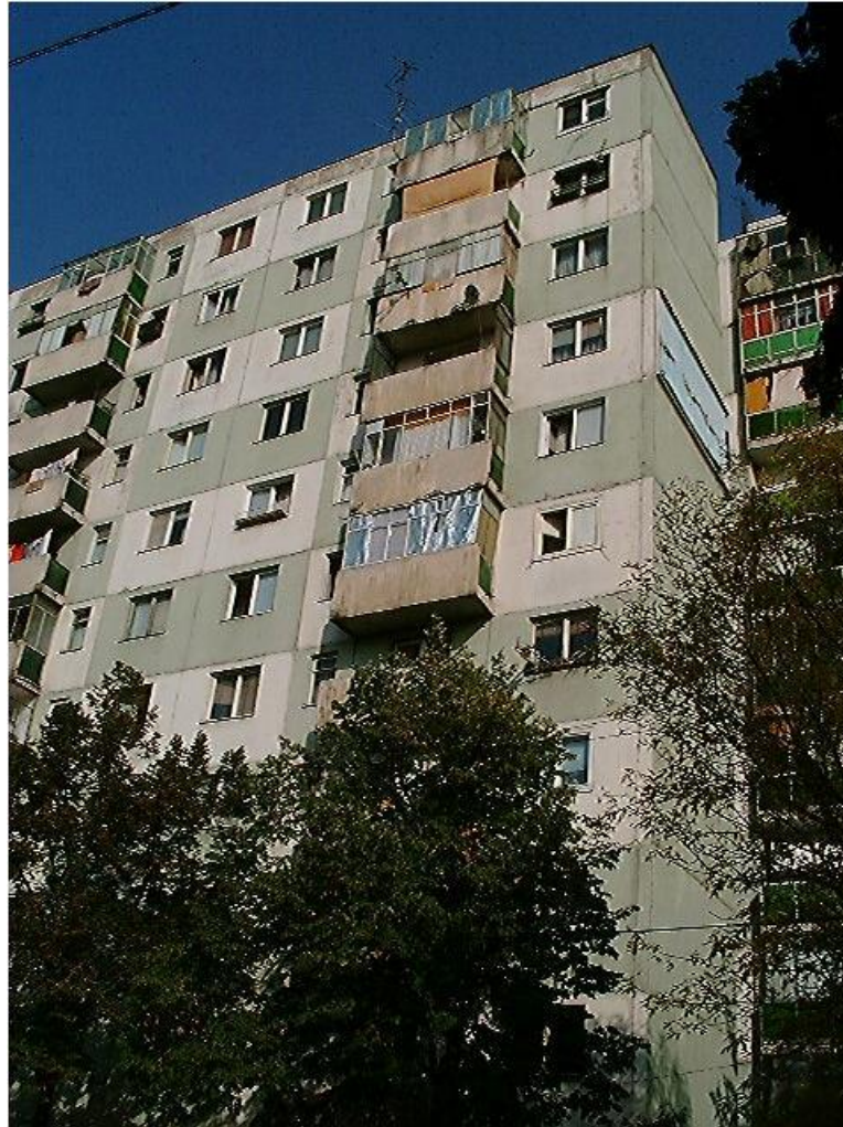
Clădire din panouri mari prefabricate din București
